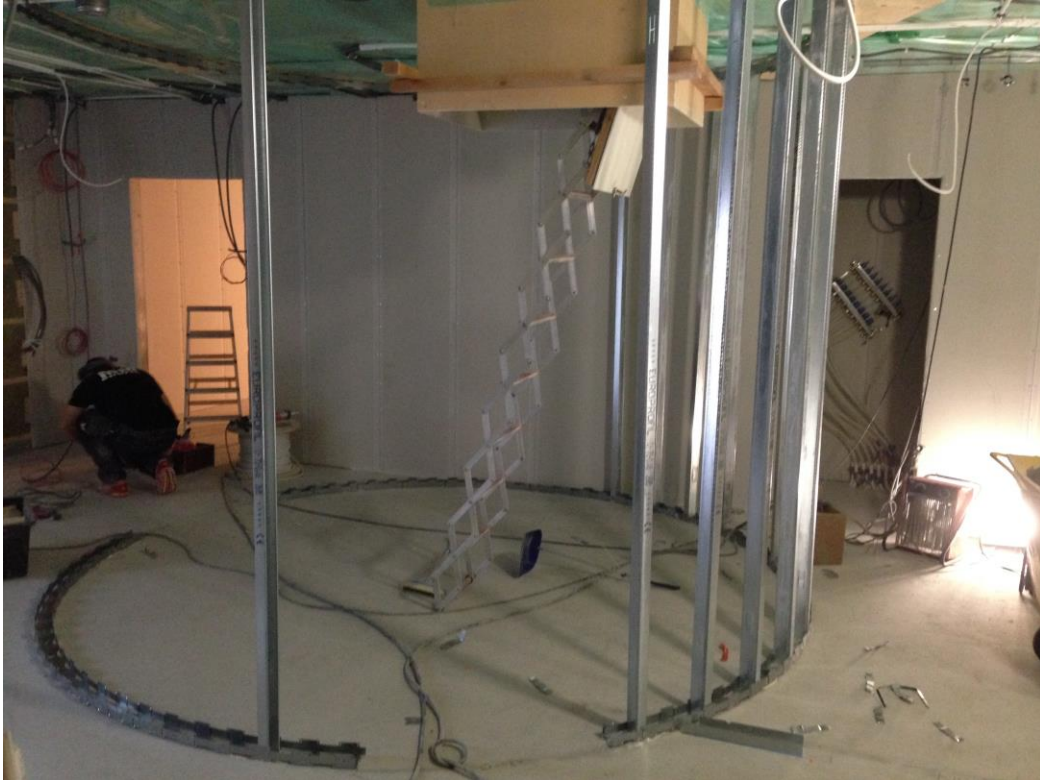
Montage av regelverk till sista runda rummet
