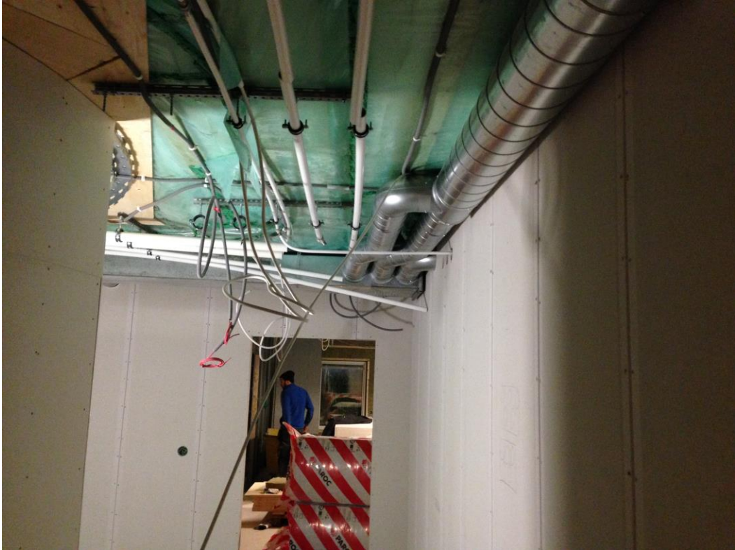
Pågående ventilation, rör och elinstallationer i tak
