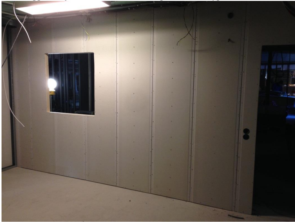
Innerväggar börjar ta form med invändiga fönstersmygar
