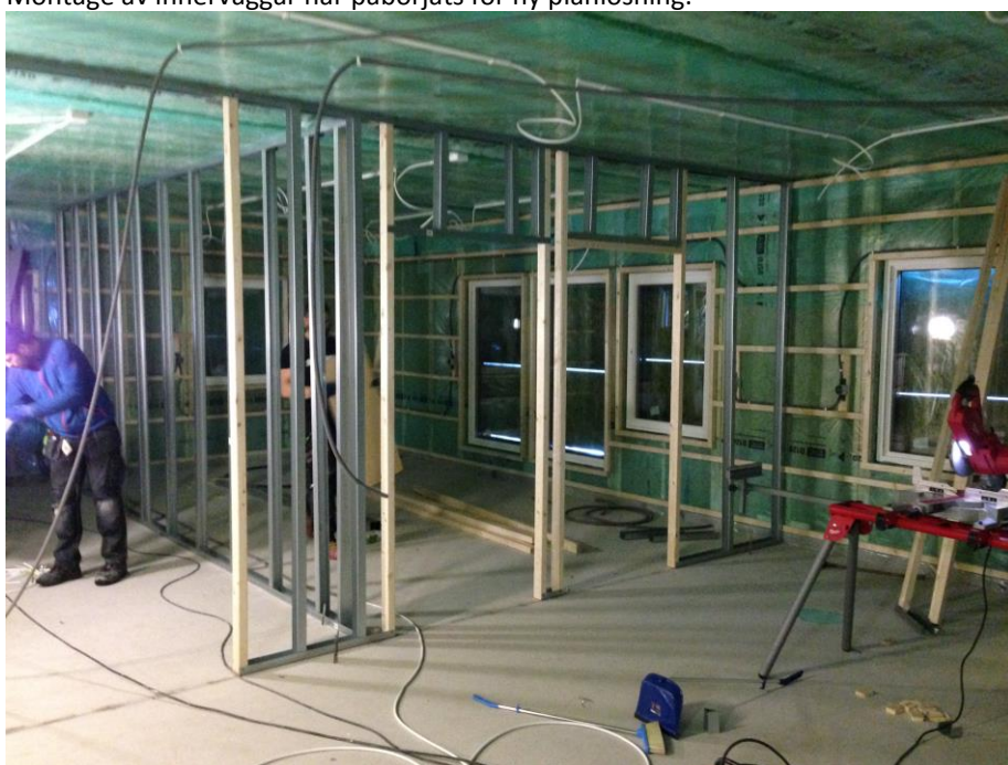
Montage av innerväggar har påbörjats för ny planlösning.
