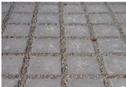
Figur 6.4 a) & b). Exempel på genomsläppliga beläggningar med gräs respektive grusfogar.
