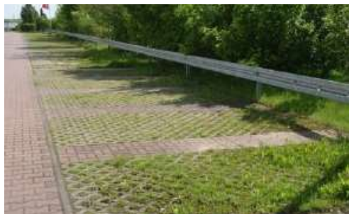
Figur 6.4 a) & b). Exempel på genomsläppliga beläggningar med gräs respektive grusfogar.
