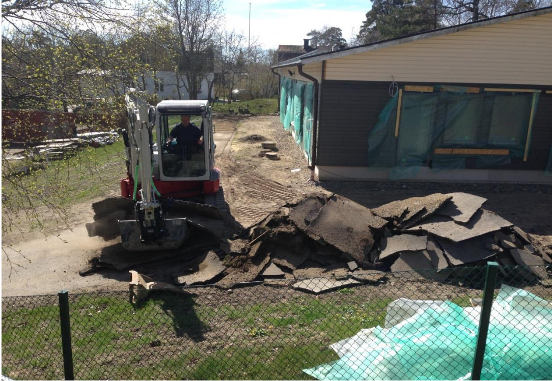
Utvändiga arbeten har påbörjats, här rivs asfalten
