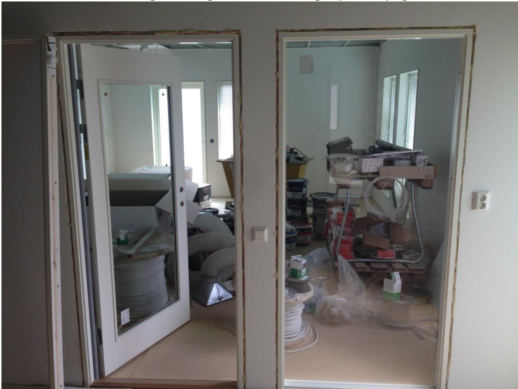
Invändigt montage av dörrar och glaspartier pågår
