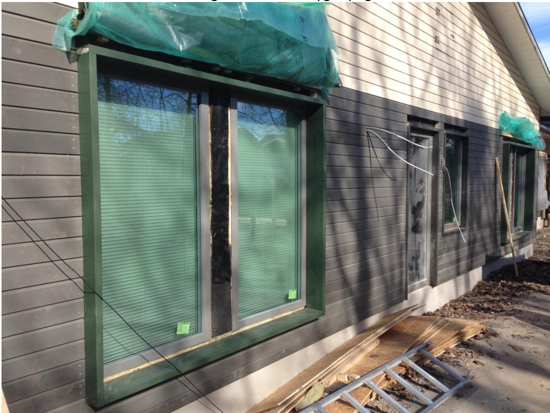
Montage av fönstersmygar pågår
