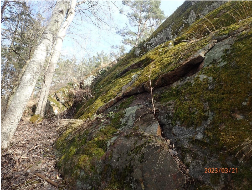
Figur 3.6. Några mindre potentiella block noterades. Ingen åtgärd bedöms nödvändig i dagsläget.
