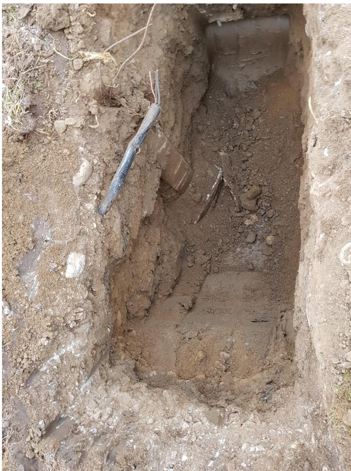
Figur 2. I flera gropar påträffades byggnadsrester. Bilden visar provgrop 19S004 där både en gammal ledning samt ett av betongfundamenten är synliga.
