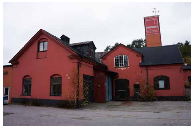
Gamla Ångbryggeriet, vy från öster
