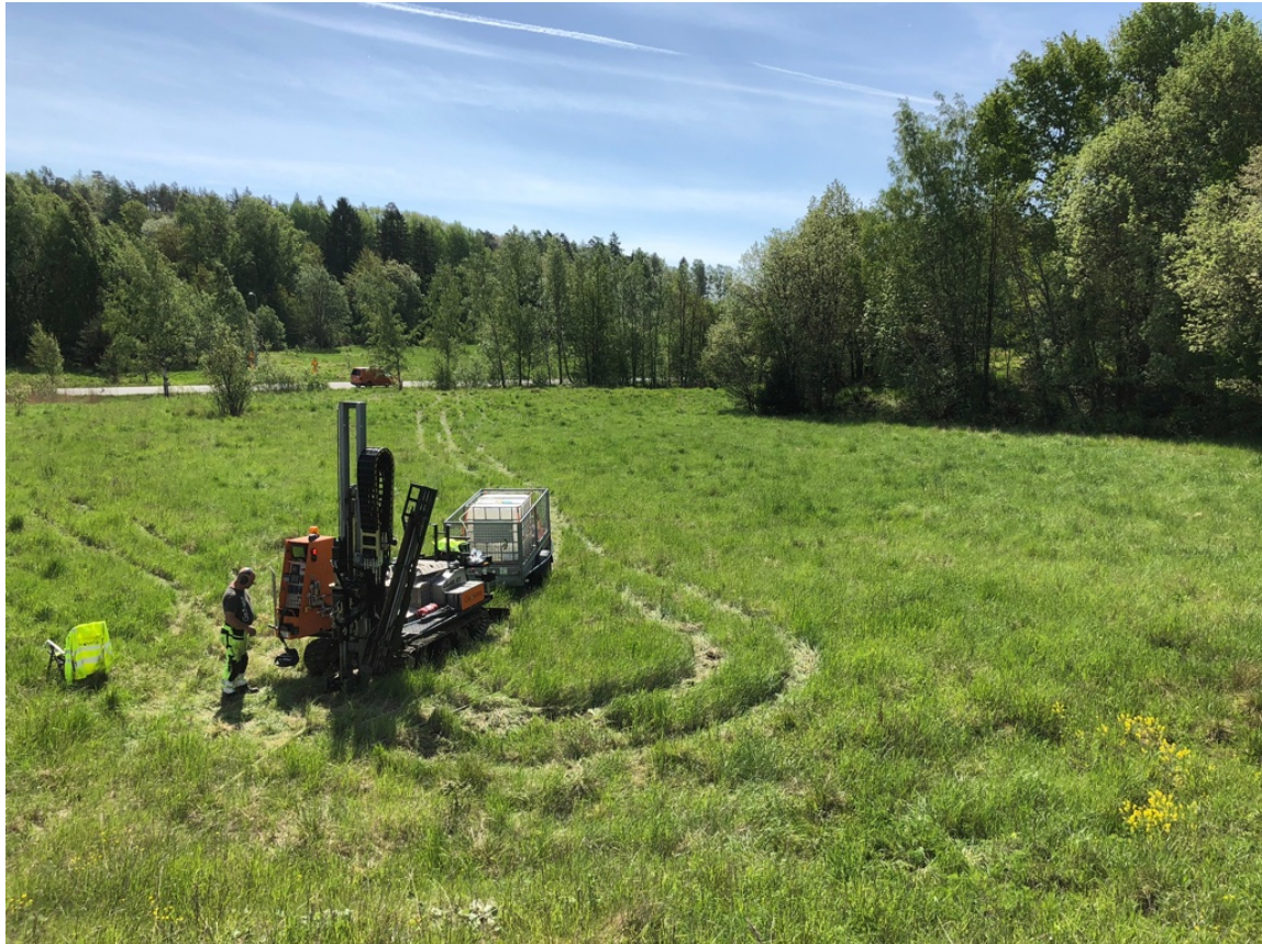
Geoteknisk markundersökning och miljöteknisk provtagning med borrhvagn på Kalvö industriområde 2019.
