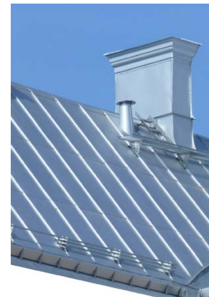
Exempel på takmaterial, aluzinkplåt.
