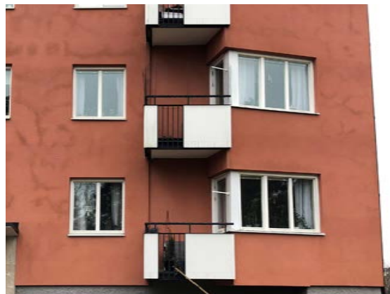
Balkongutformning på befintliga hus längs Höjdgatan.
