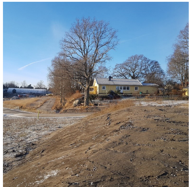
Slänten mellan den övre och nedre nivån inom skolgården, februari 2022.
