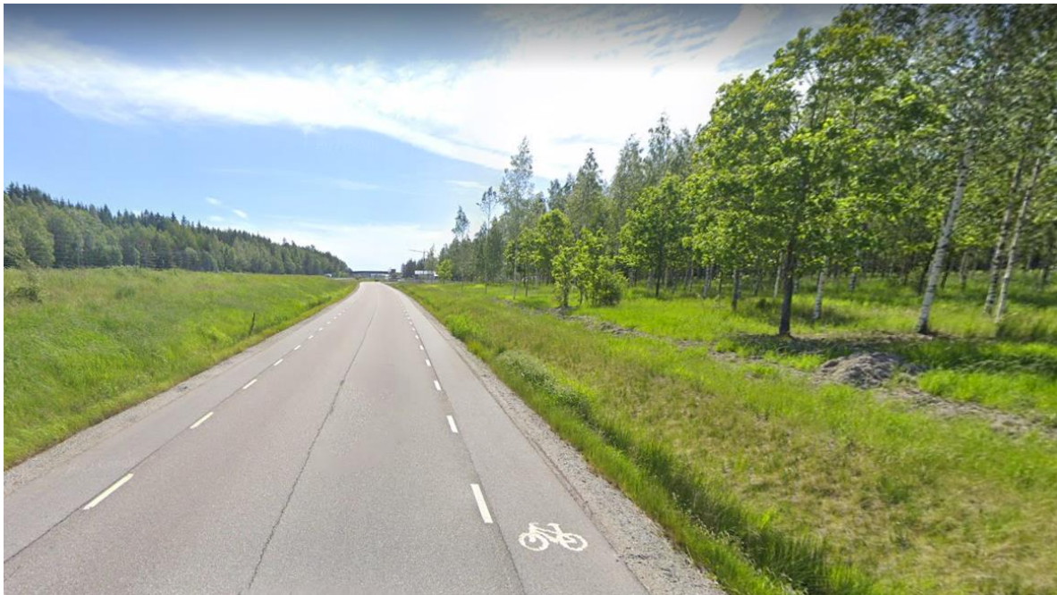
Figur 6 Väg 545 med detaljplaneområdet till höger om vägen. Skärmbild från Google Street View. 11
